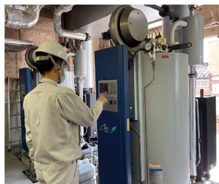
設備点検作業の様子
